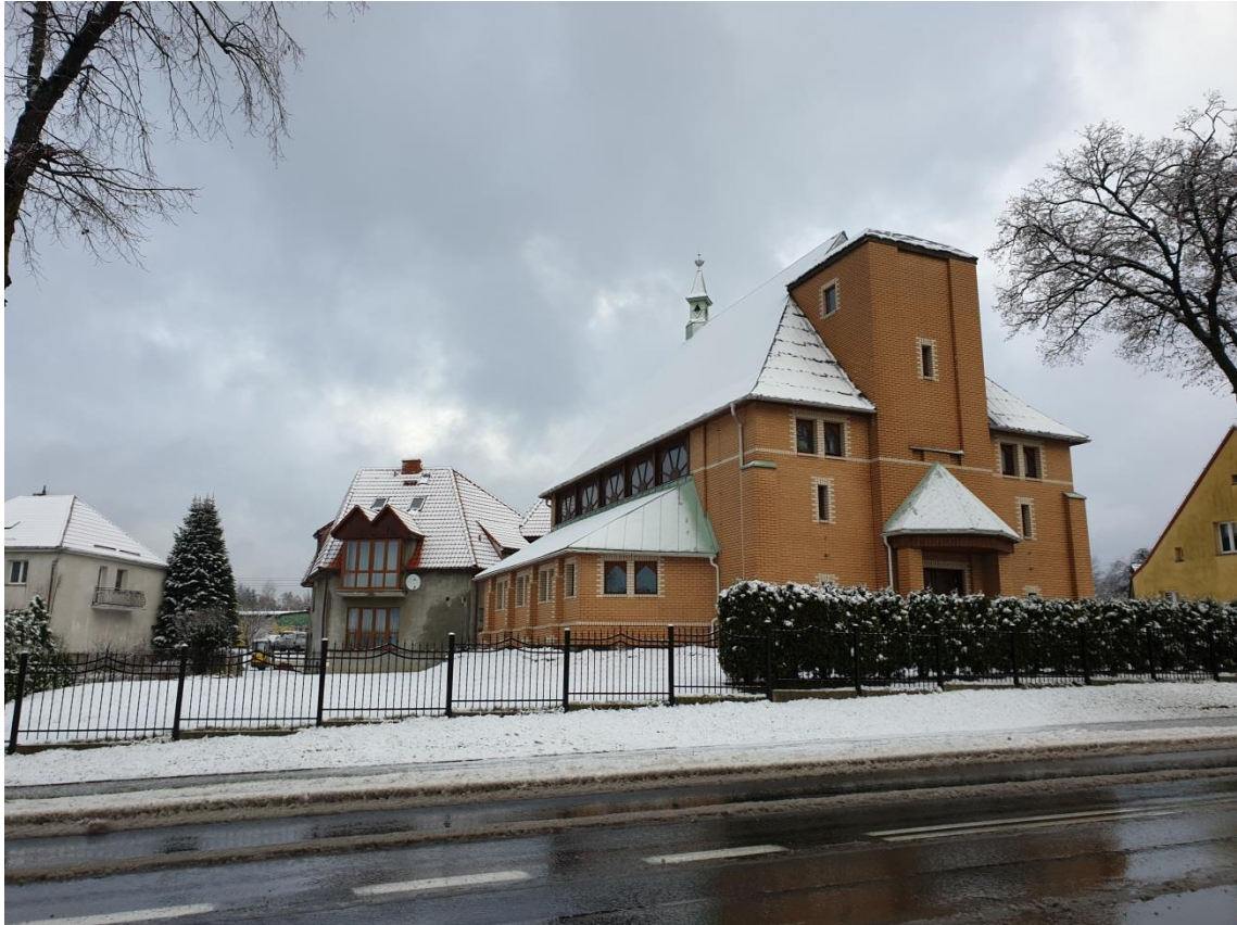
Rysunek 2. Widok z drogi krajowej na obszar opracowania planu – kościół oraz plebanię (w tle)
