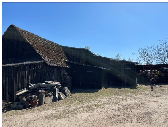
Fot. 4 Budynki gospodarczo-garażowe na dz. nr 245/4 Źródło: archiwum własne, stan na 09.05.2023r.
