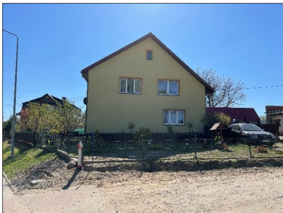
Fot. 1 Budynek mieszkalny na dz. nr 245/2 Źródło: archiwum własne, stan na 09.05.2023r.
