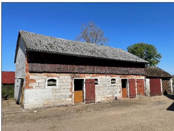
Fot. 3 Budynki gospodarczo-garażowe na dz. nr 245/4 Źródło: archiwum własne, stan na 09.05.2023r.
