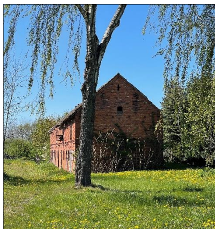
Fot. 1 Budynek inwentarski na obszarze objętym MPZP
