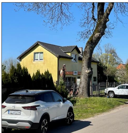
Fot. 3 Budynek mieszkalno-usługowy na dz. nr 129 Źródło: archiwum własne, stan na 09.05.2023r.
