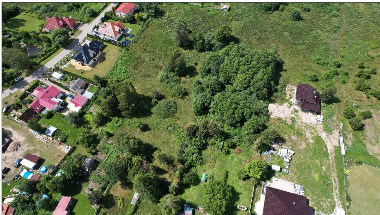
Fot. 13 Widok na teren 11-MN
