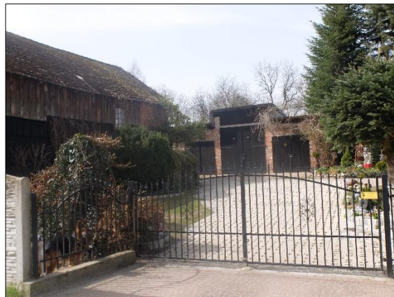
Fot. 20 Budynek gospodarczy na dz. nr 227 Źródło: archiwum własne, stan na 13.04.2022
