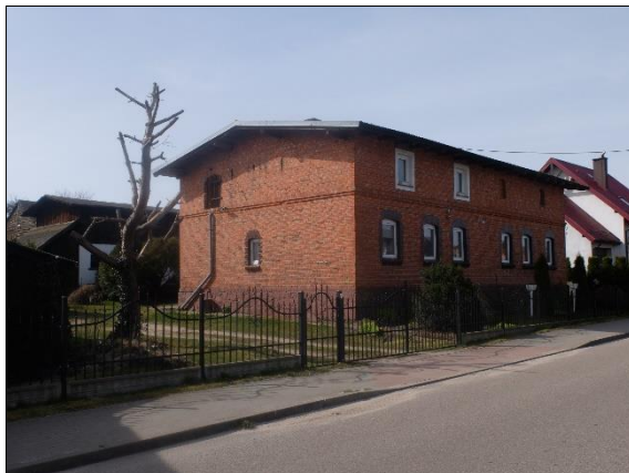
Fot. 16 Budynek mieszkalny (Gwiazdowo 48) Źródło: archiwum własne, stan na 13.04.2022
