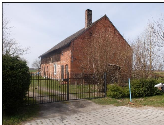
Fot. 18 Budynek gospodarczy na dz. nr 327/5 Źródło: archiwum własne, stan na 13.04.2022
