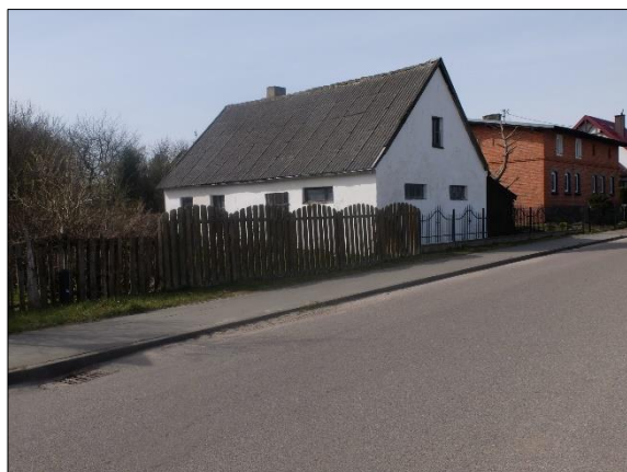
Fot. 17 Budynek gospodarczy na dz. nr 221 Źródło: archiwum własne, stan na 13.04.2022
