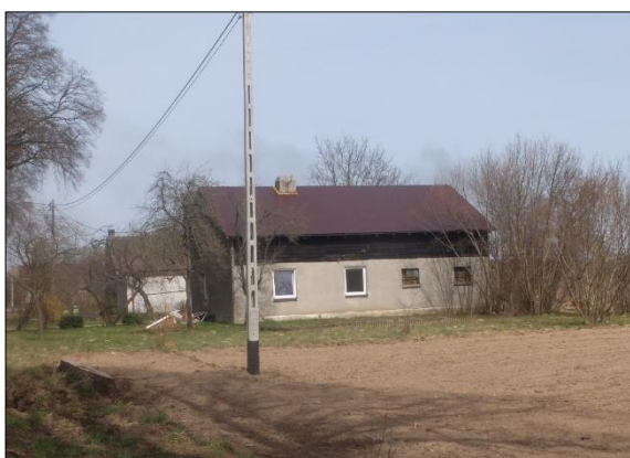
Fot. 21 Budynek mieszkalny na dz. nr 305/2 Źródło: archiwum własne, stan na 13.04.2022
