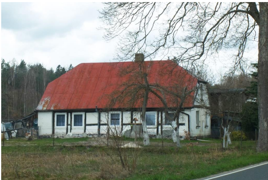
Fotografia 30. Chałupa w miejscowości Pomiłowo typowana do ujęcia w gminnej ewidencji zabytków. Budynek w charakterze regionalnej architektury o konstrukcji ryglowej, nakryty wysokim dachem dwuspadowym.
