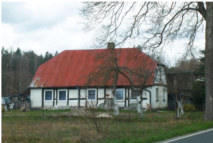
Fotografia 30. Chałupa w miejscowości Pomiłowo typowana do ujęcia w gminnej ewidencji zabytków. Budynek w charakterze regionalnej architektury o konstrukcji ryglowej, nakryty wysokim dachem dwuspadowym.
