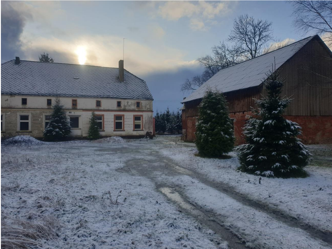
Rysunek 4. Budynek mieszkalny oraz budynek gospodarczy.
