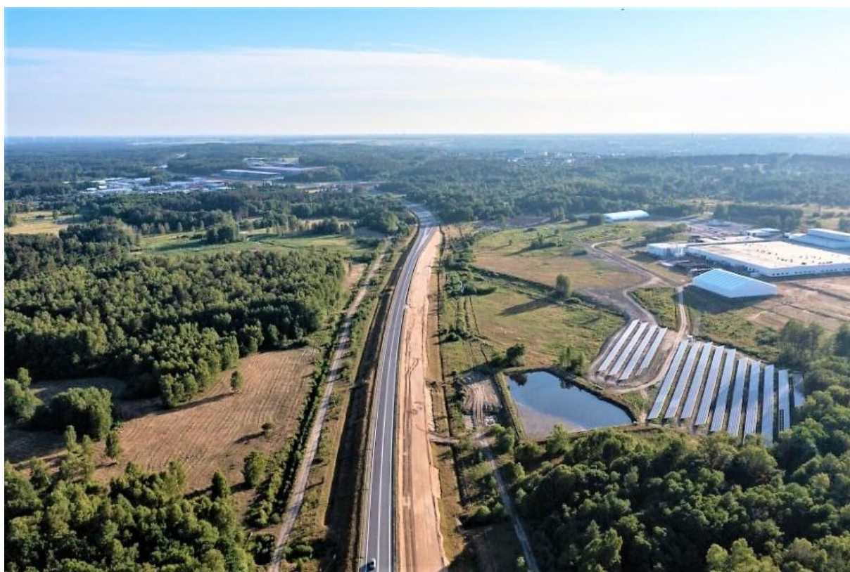
Fot. 5. Budowa drogi S6 koło Wrześnicy
