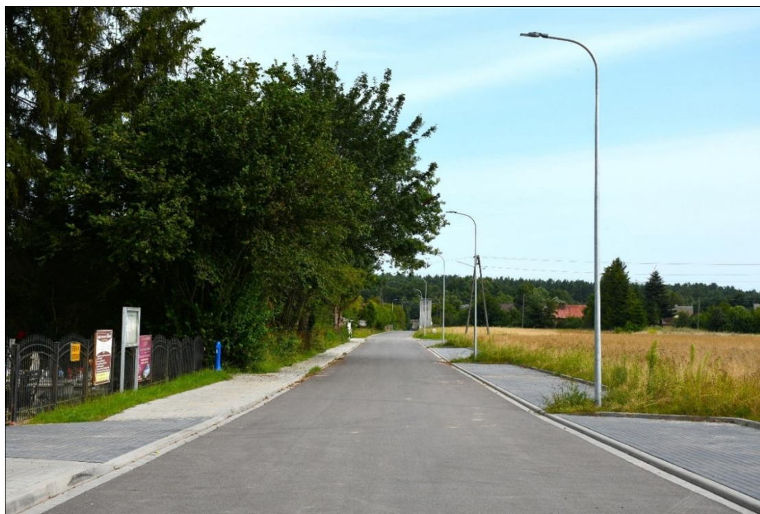
Oświetlenia uliczne drogi gminnej we Wrześnicy
