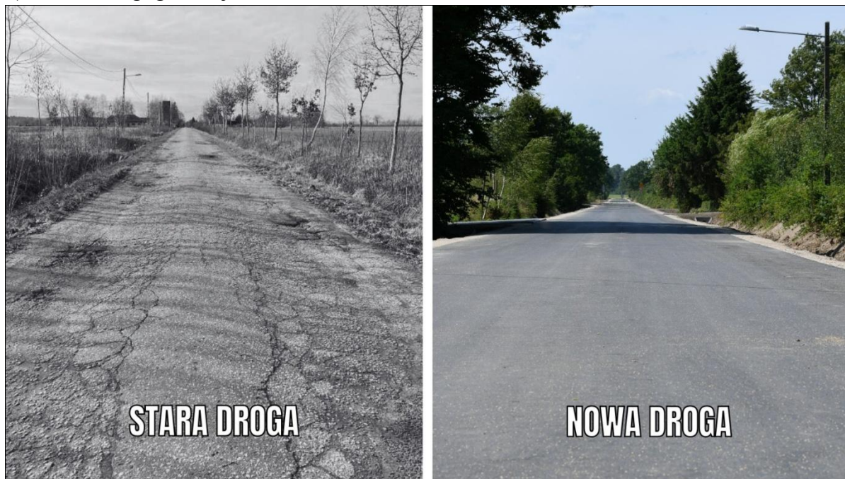
Droga w Tokarach przed i po remoncie
