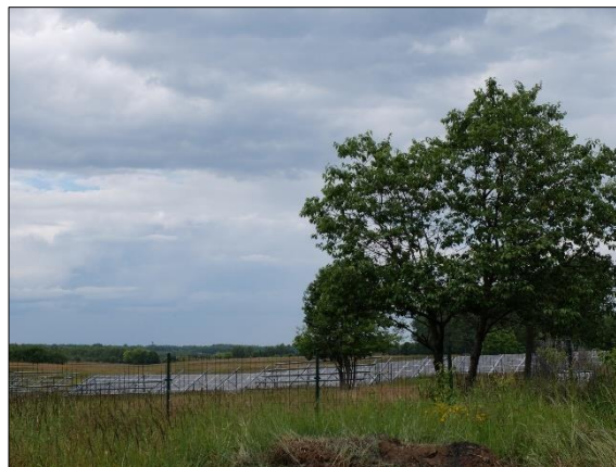
Fot. 7 Instalacja fotowoltaiczna Źródło: archiwum własne
