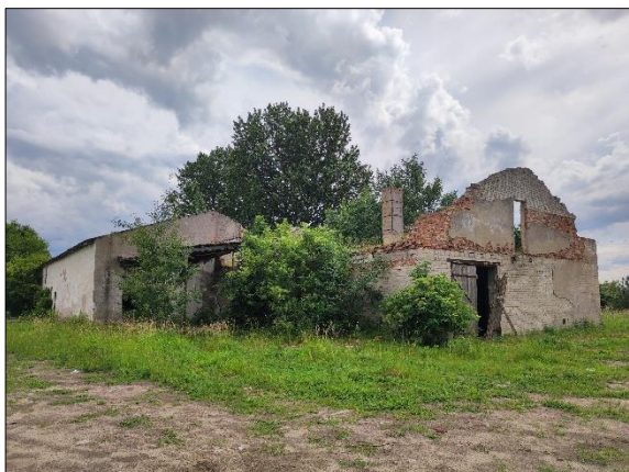
Fot. 4 Pozostałości po budynku gospodarczym Źródło: archiwum własne
