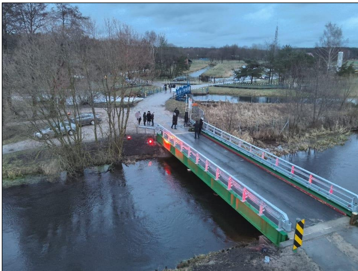
Wyremontowany most w Pomilowie
