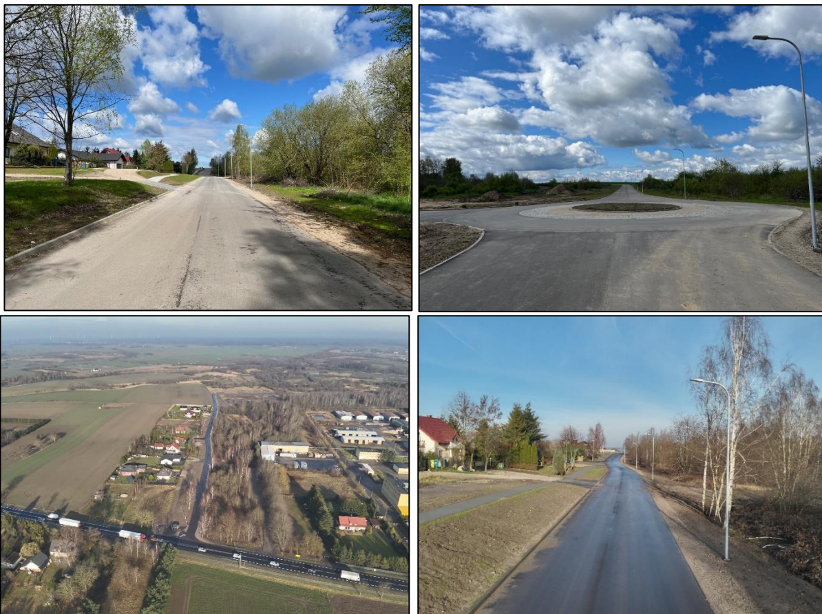
Droga dojazdowa do strefy gospodarczej w Bobrowiczkach
