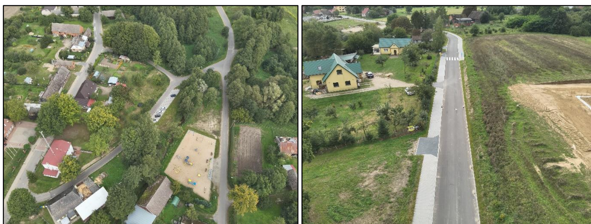
Przebudowana infrastruktura drogowa w Bobrowicach
