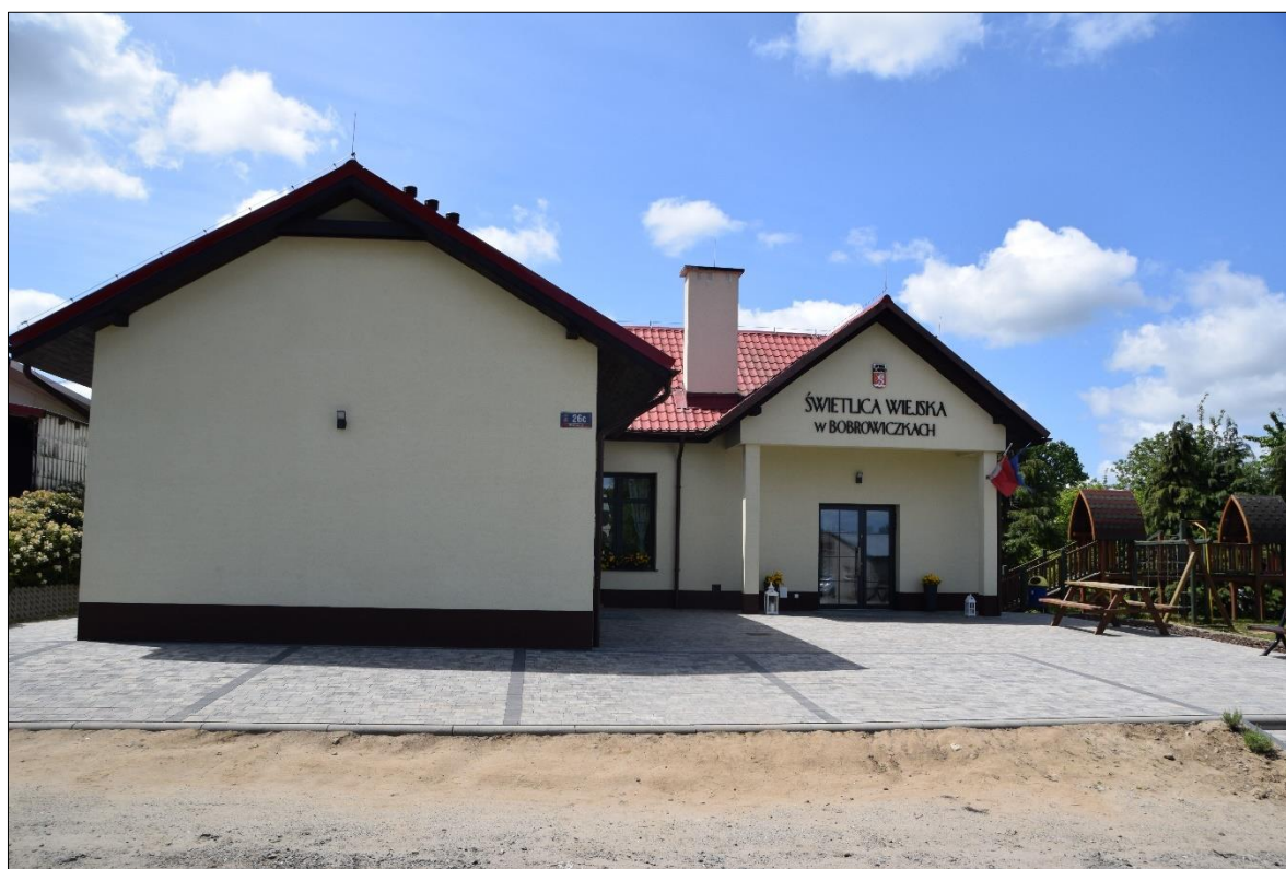
Termomodernizacja i rozbudowa świetlicy wiejskiej w Bobrowiczkach
