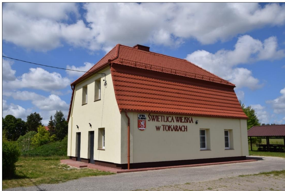
Termomodernizacja i remont świetlicy wiejskiej w Tokarach
