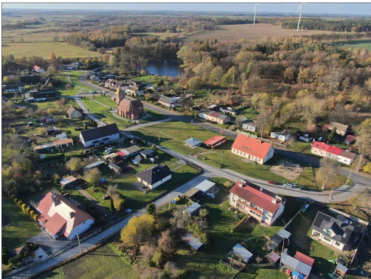
Przebudowane ciągi komunikacyjne w Tychowie
