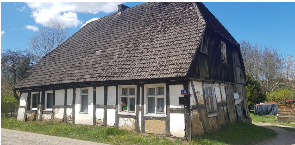
Fotografia 11. Chałupa z 2 ćw. XIX w. pod adresem Bobrowice 8 ujęta w wojewódzkiej ewidencji zabytków. Budynek w charakterze regionalnej architektury o konstrukcji ryglowej, nakryty wysokim dachem dwuspadowym z zachowanymi elementami historycznej stolarki
