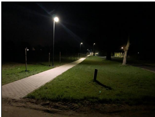
Oświetlenie ciągu pieszego w Tychowie
