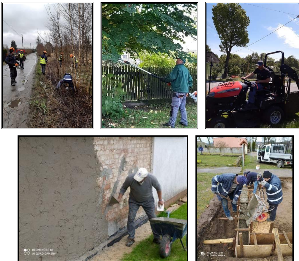
Warsztat konserwacji terenów zielonych i warsztat prac remontowo-budowlanych
