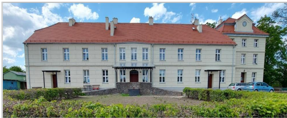
Pałac w Kwasowie - wspólnota mieszkaniowa Kwasowo 1 przed i po kompleksowym remoncie i termomodernizacji
