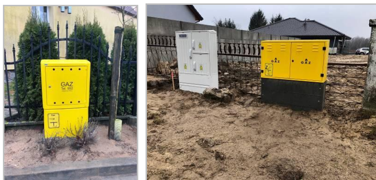
Przyłącza gazu ziemnego wybudowane w Warszkwie
