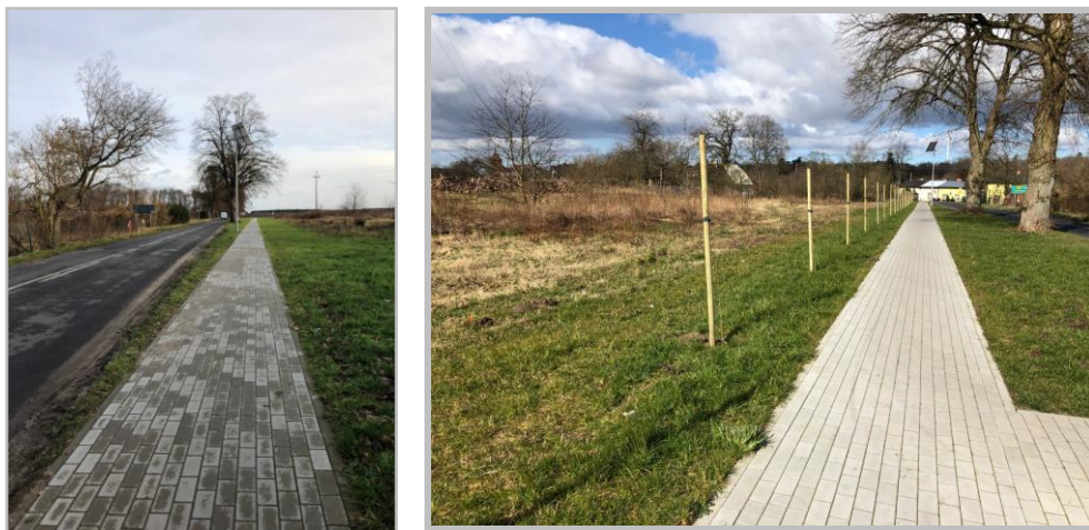
Wybudowano chodnik wzdłuż drogi wojewódzkiej w Tychowie
