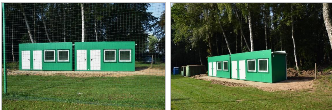
Dwa kontenery socjalne pełnią funkcję szatni na boisku w Tychowie
