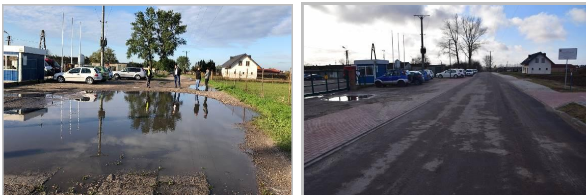
W Warszkwie przebudowano ulicę Słoneczną i fragment ulicy Mieszka I – na zdjęciach droga przed i po przebudowie w okolicach Fabryki Przetworów Rybnych „Mieszko”
