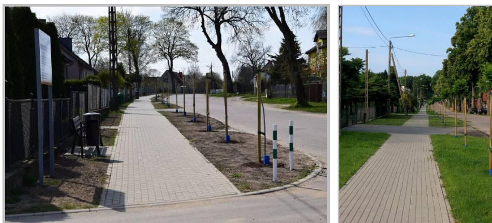
Nowy chodnik ze zjazdami, lawkami i koszami na śmieci powstał w Rzyszczewie
