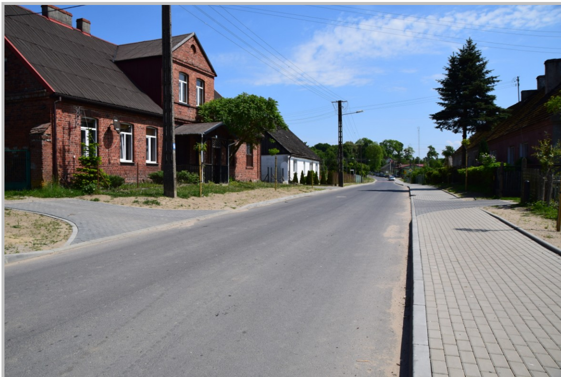
Przebudowana droga gminna w Janiewicach
