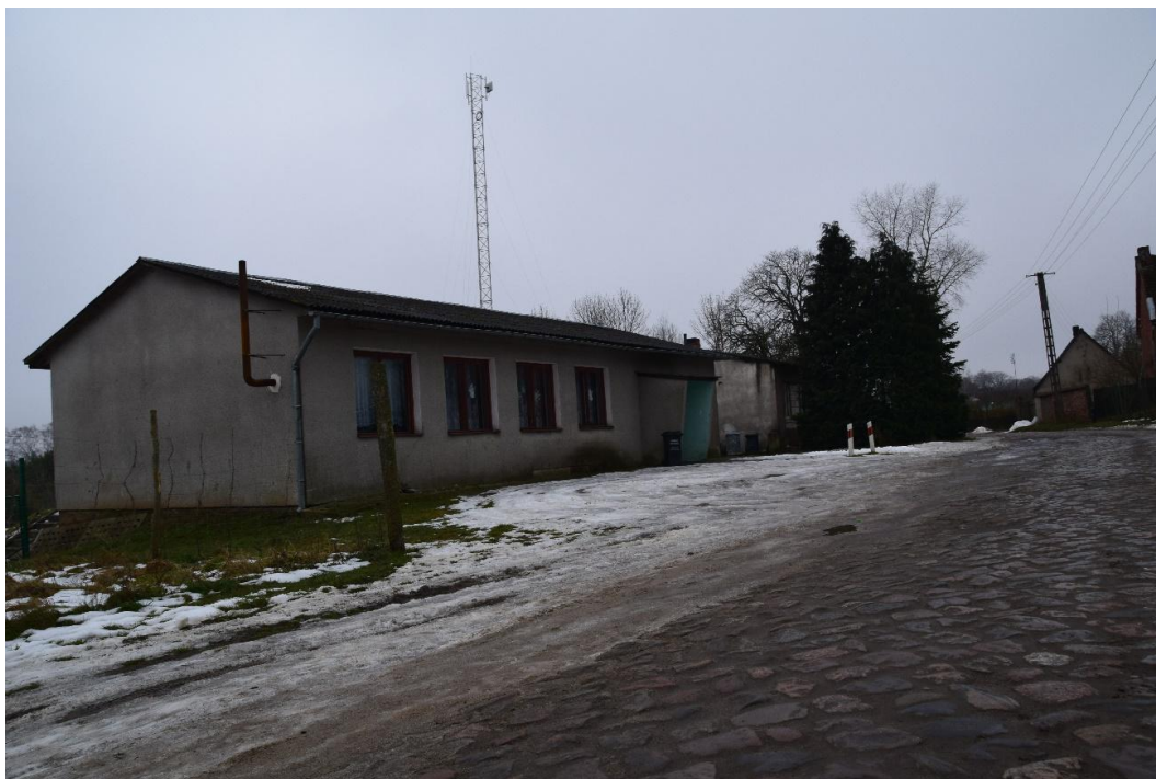
Świetlica wiejska i główna droga gminna w Warszkówku
