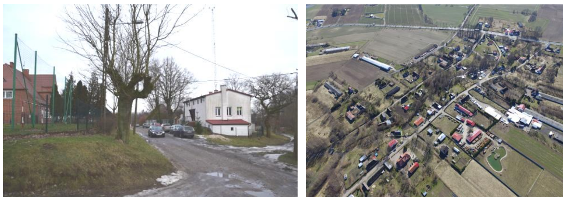
Fot. Bobrowice- główna droga w centrum miejscowości. Po obu stronach ulicy budynki szkoły podstawowej
