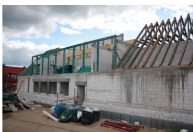
Budowa szkoły w Żukowie /fot. IX 2016 r./
