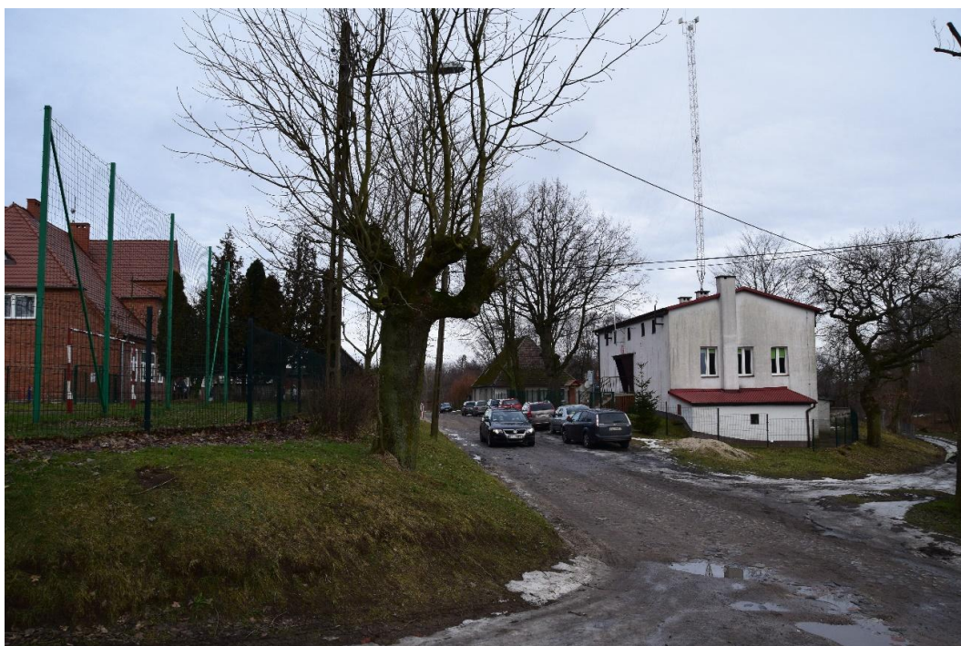
Droga brukowa obok budynków szkolnych w Bobrowicach
