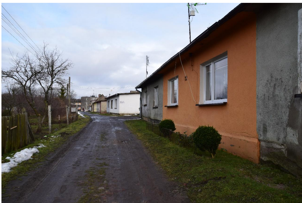
Droga gminna prowadząca na osiedle byłych pracowników PGR w Rzyszczewie
