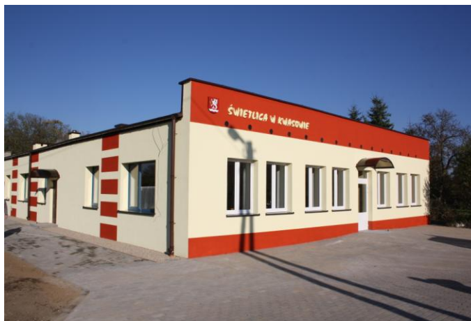
Fot. Budynek świetlicy w Kwasowie
