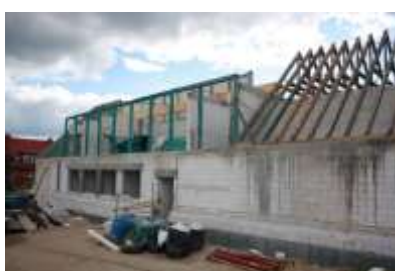
Budowa szkoły w Żukowie /fot. IX 2016 r./
