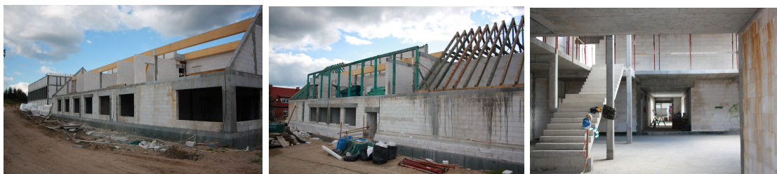
Budowa szkoły w Żukowie /fot. IX 2016 r./
