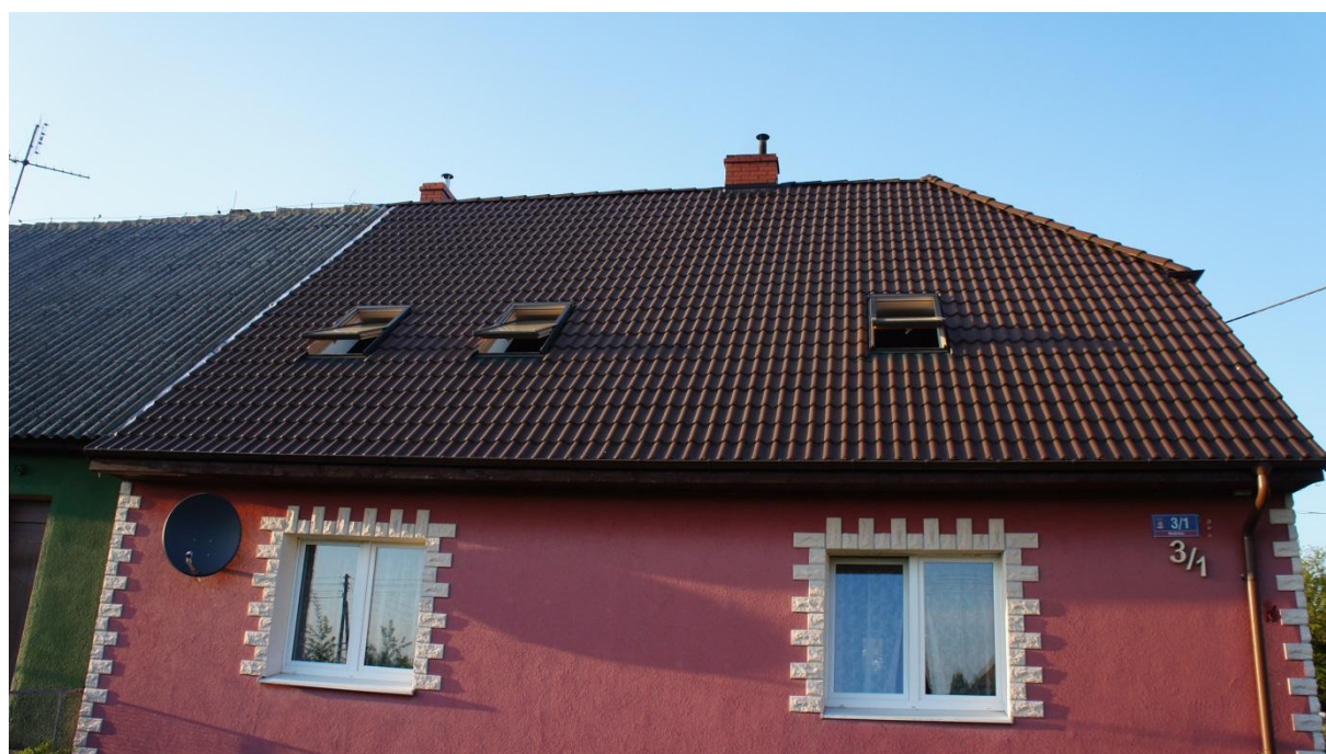
Rysunek 78 - Umiejscowienie systemu PV na nieruchomości – wybór połaci dachowej
