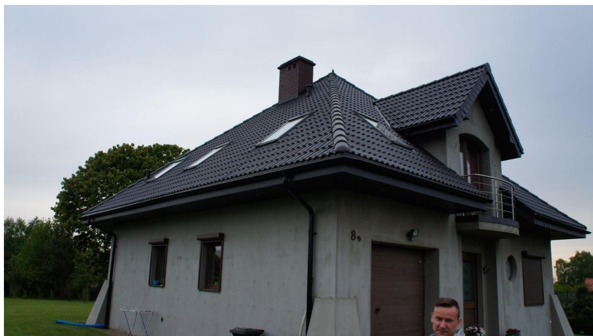
Rysunek 22 - Umiejscowienie systemu PV na nieruchomości – wybór połaci dachowej
