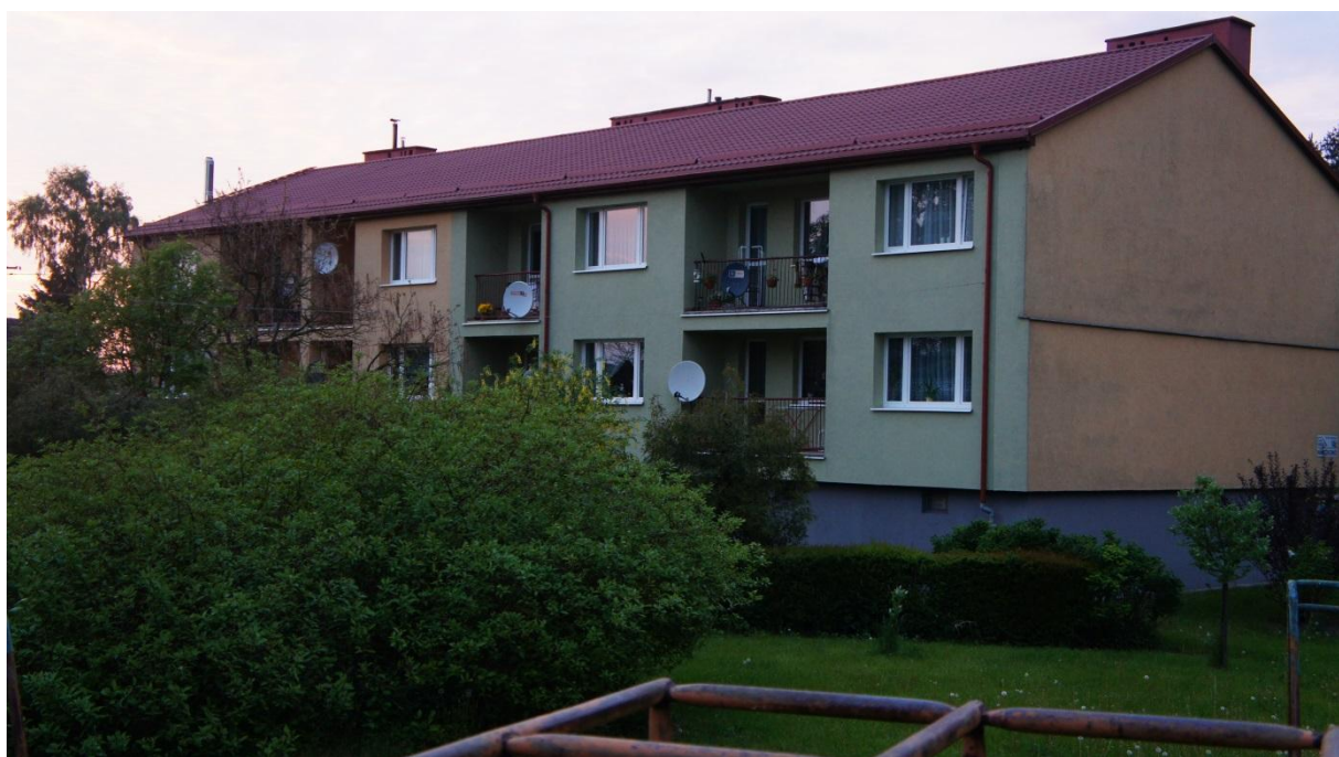
Rysunek 62 - Umiejscowienie systemu PV na nieruchomości – wybór połaci dachowej
