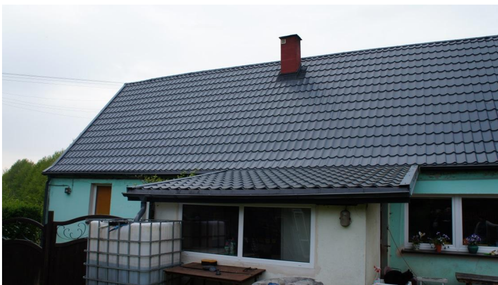
Rysunek 18 - Umiejscowienie systemu PV na nieruchomości – wybór połaci dachowej
