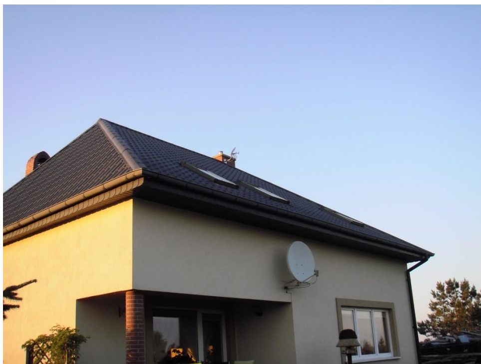
Rysunek 154 - Umiejscowienie systemu PV na nieruchomości – wybór połaci dachowej
