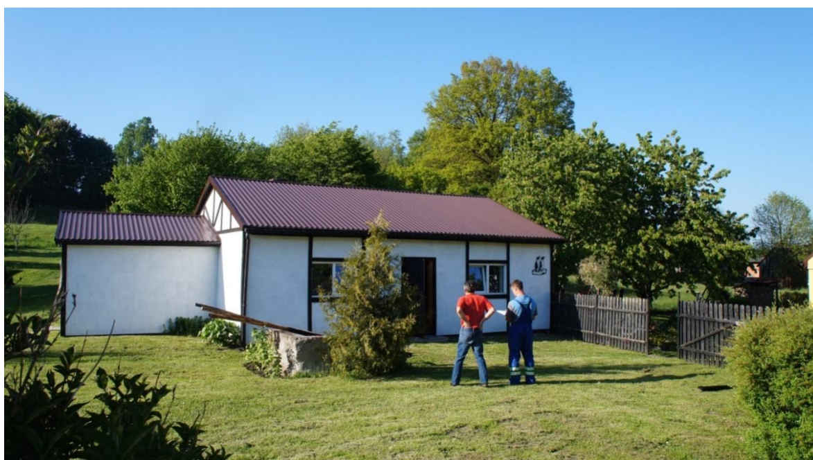
Rysunek 170 - Umiejscowienie systemu PV na nieruchomości – wybór połaci dachowej
