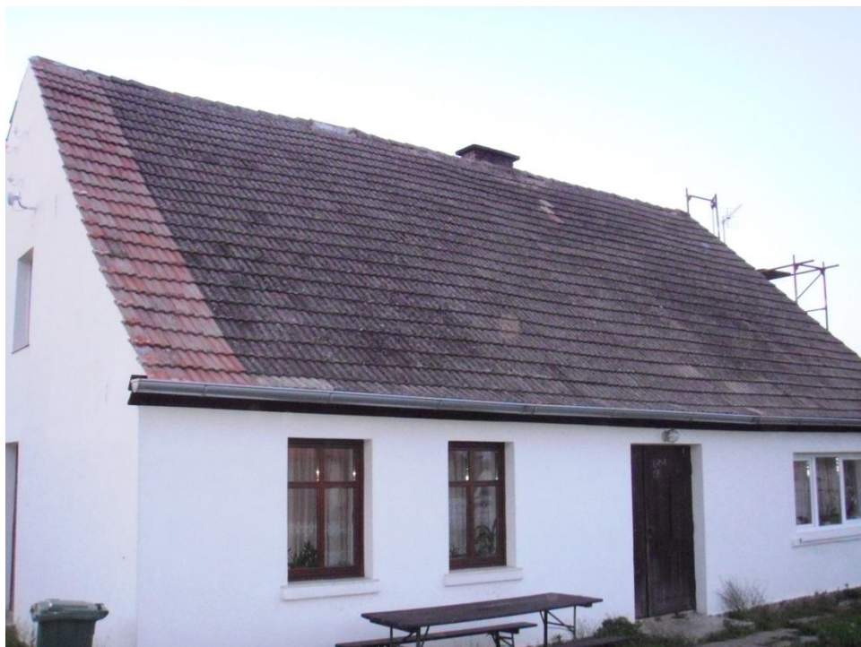
Rysunek 158 - Umiejscowienie systemu PV na nieruchomości – wybór połaci dachowej
