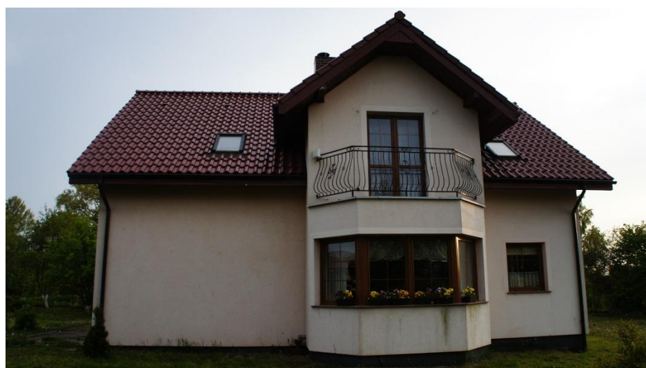
Rysunek 34 - Umiejscowienie systemu PV na nieruchomości – wybór połaci dachowej
