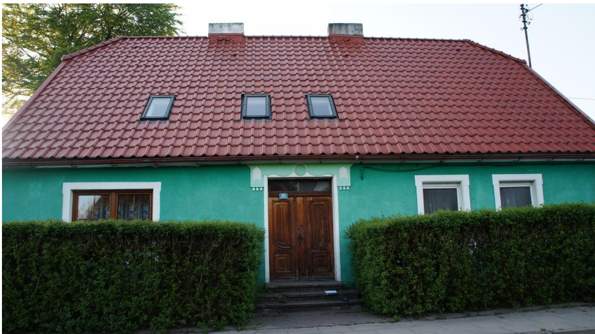
Rysunek 114 - Umiejscowienie systemu PV na nieruchomości – wybór połaci dachowej
