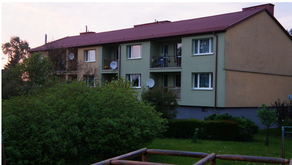
Rysunek 54 - Umiejscowienie systemu PV na nieruchomości – wybór połaci dachowej
