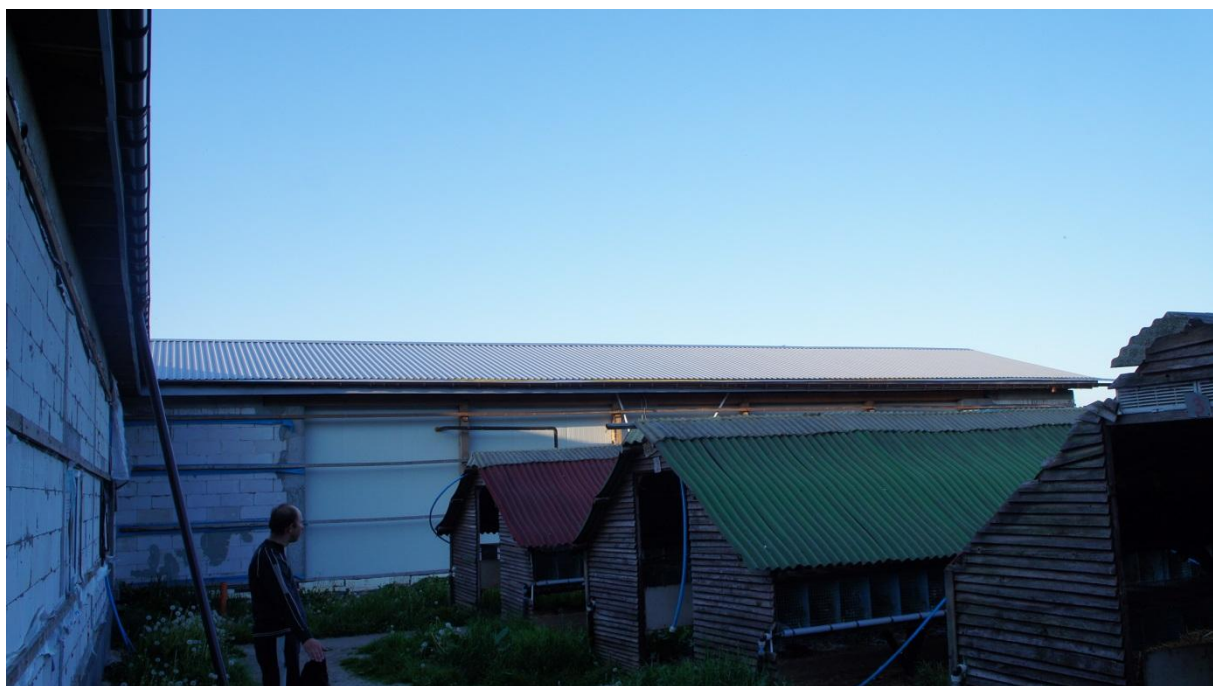
Rysunek 138 - Umiejscowienie systemu PV na nieruchomości – wybór połaci dachowej
